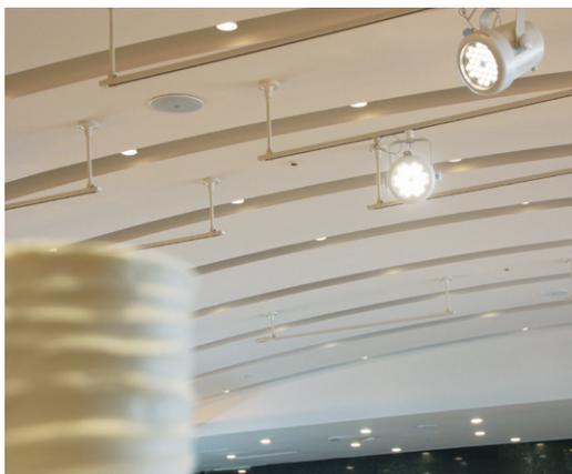
色温度や配光角度は3種類ずつで計9種類の仕様があります。また、取り付け部分の角度変化が可能な精円配光フィルタ (SL2) も備えています。これらの装備により、明かりをもう少し伸ばしたい時や、球向きの角度を変えたい時にも簡単に対応できます。
